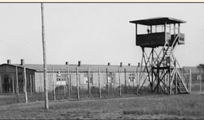
Wachttoren, omheining en barakken
